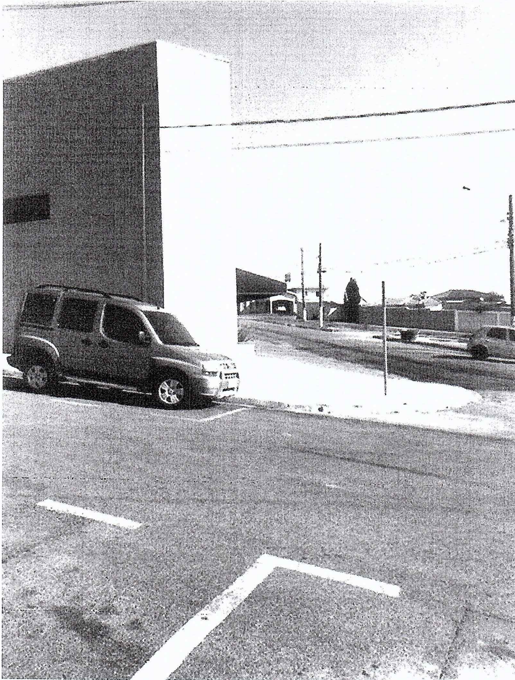
Registro fotográfico 002 – Chanfrado da Construção.
