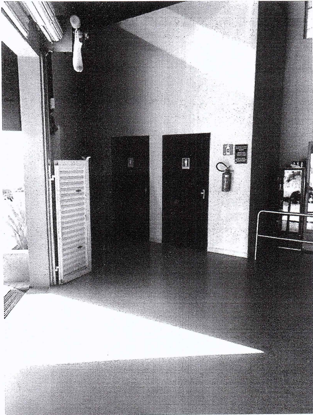
Registro fotográfico 004 – Banheiros da edificações.
