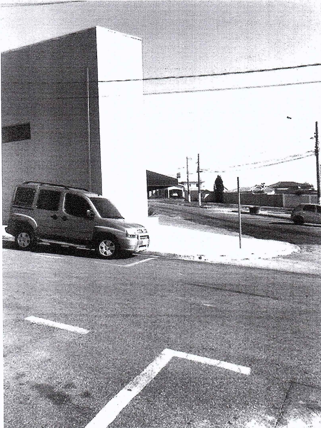
Registro fotográfico 002 – Chanfrado da Construção.
