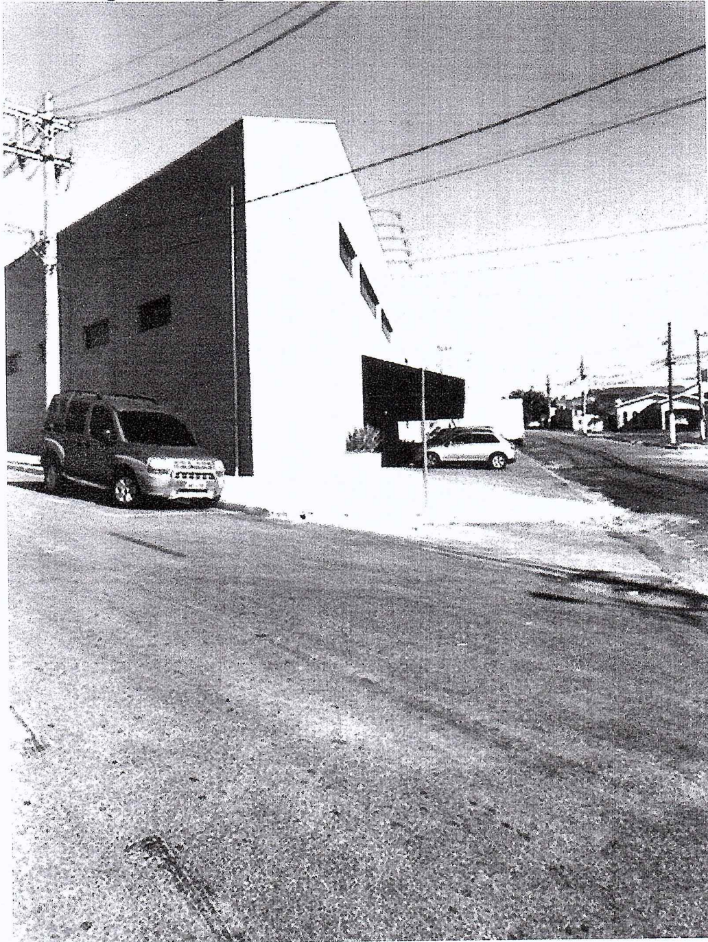
Registro fotográfico 001 – Chanfrado da Construção.
