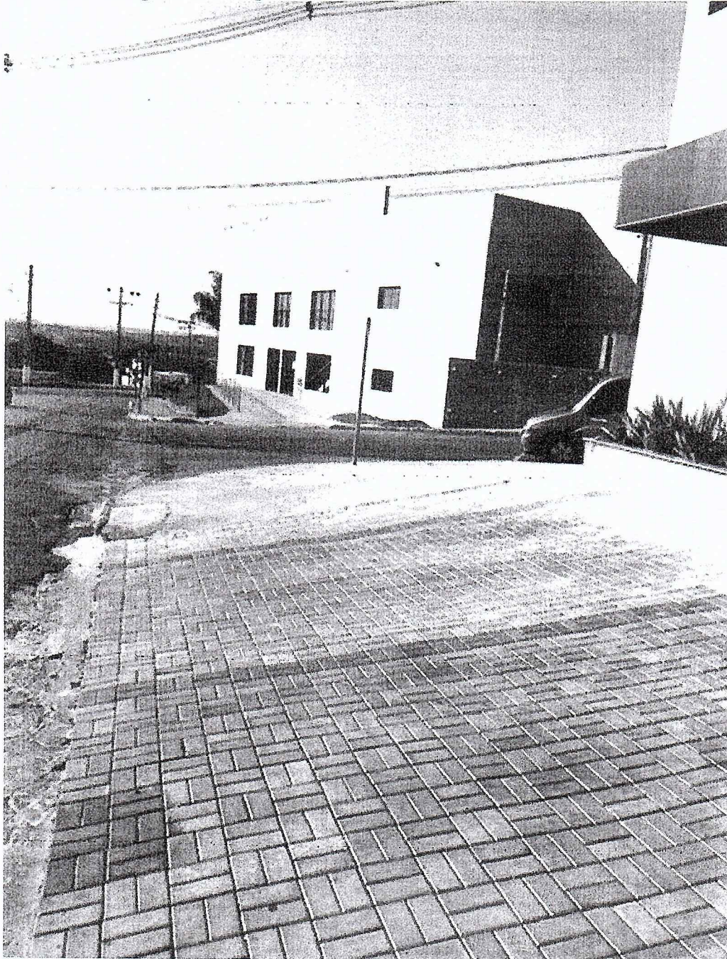
Registro fotográfico 003 – Recuo da Edificação.
